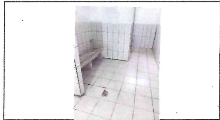
Foto 2: Area Sanitarios de Hombres
