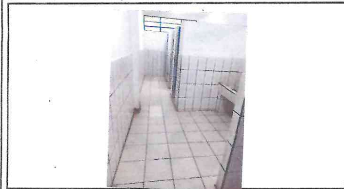
Foto 1: Area Sanitario de Mujeres
